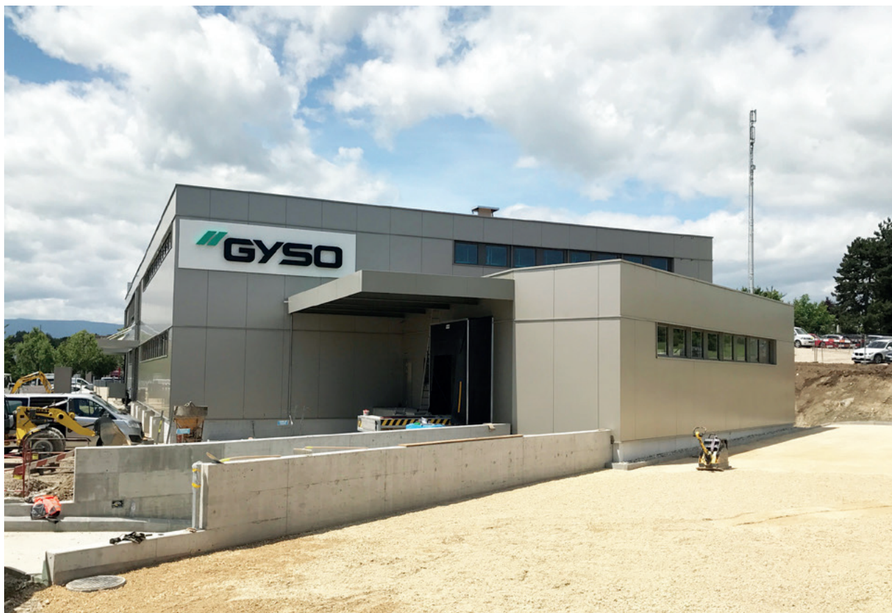
Filiale Crissier 2017- Umsetzung der Fassadenbekleidung mittels DOWSIL PanelFix System
