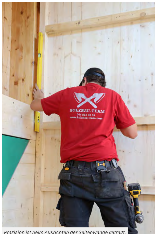
Präzision ist beim Ausrichten der Seitenwände gefragt.
