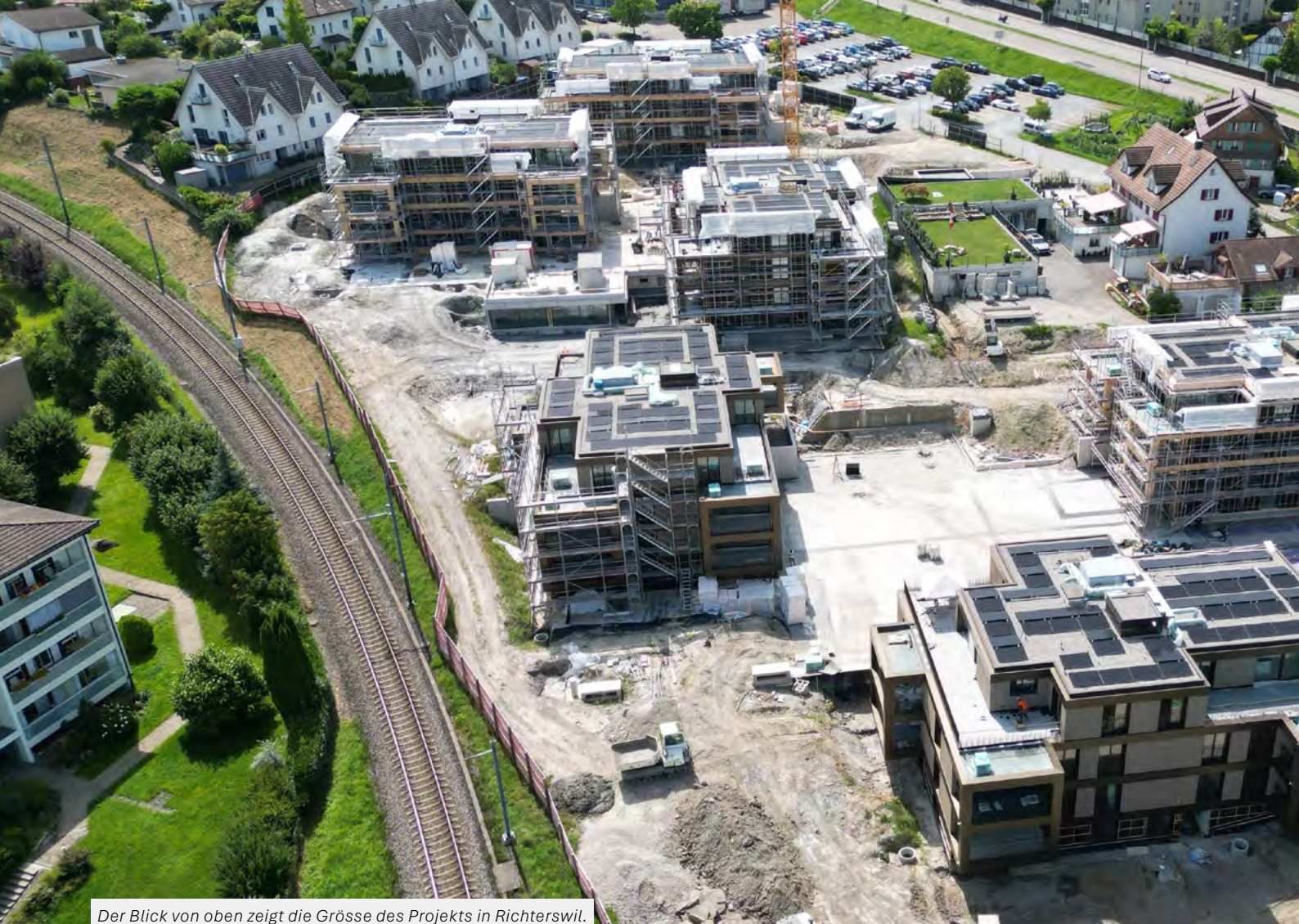
Der Blick von oben zeigt die Grösse des Projekts in Richterswil.
