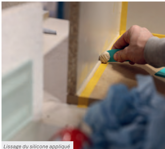
Lissage du silicone appliqué
