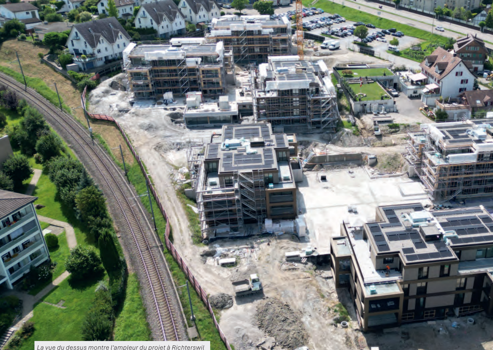
La vue du dessus montre l'ampleur du projet à Richterswil
